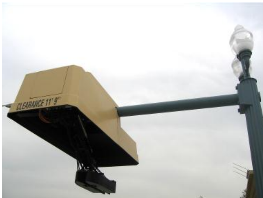
KUVA 7: Proterra FastFill™ – latausjärjestelmän anturi (kuva: Veolia Environment R&I, Werner Nuchterlein)
