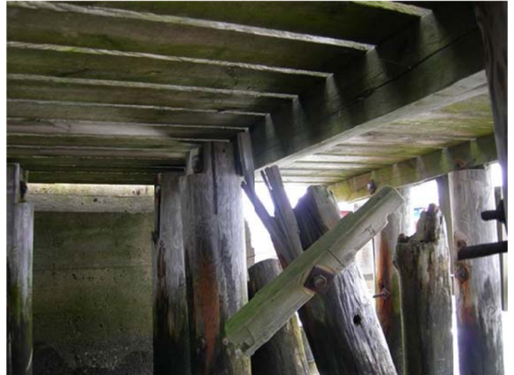
Kuva 91: Tervasaaren huonokuntoinen puulaituri
